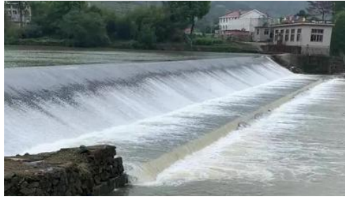
河道中斜坝急流区段
